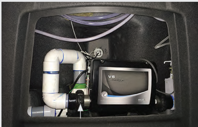
FIGURE 1.2a : BAGUE DU CHAUFFE-EAU ; DESSERREZ POUR LAISSER S'ÉCHAPPER L'AIR
