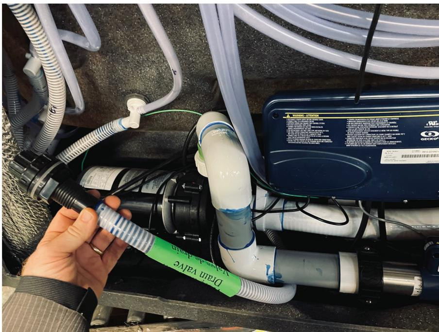
Pour y accéder, vous devez **retirer le panneau qui se trouve sous le clavier**. Le tuyau du drain, identifié par un **autocollant vert**, est situé sous le spa pack. Parfois, il peut être caché derrière la pompe.
