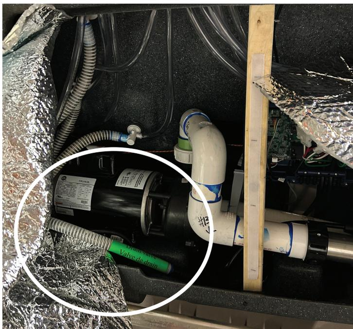
Pour y accéder, vous devez **retirer le panneau qui se trouve sous le clavier**. Le tuyau du drain, identifié par un **autocollant vert**, est situé vers la droite. Parfois, il peut être caché derrière le spa pack ou la pompe.
