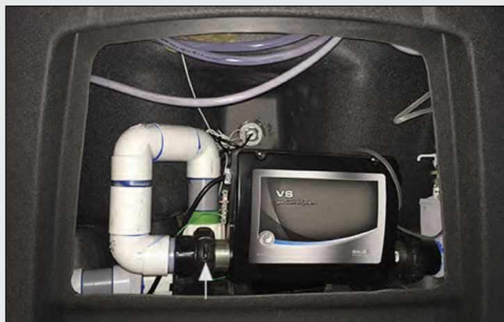
FIGURE 1.5a : BAGUE DU CHAUFFE-EAU; DESSERREZ POUR LAISSER S'ÉCHAPPER L'AIR
