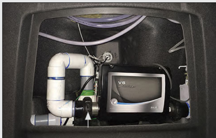
FIGURE 1.2a : BAGUE DU CHAUFFE-EAU; DESERREZ POUR LAISSER S'ÉCHAPPER L'AIR
